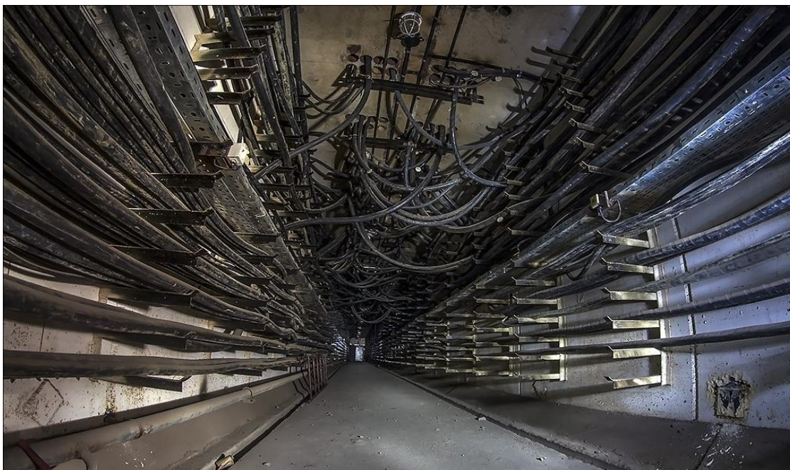
Рисунок 1.4 – Расположение кабельной продукции в туннелях
